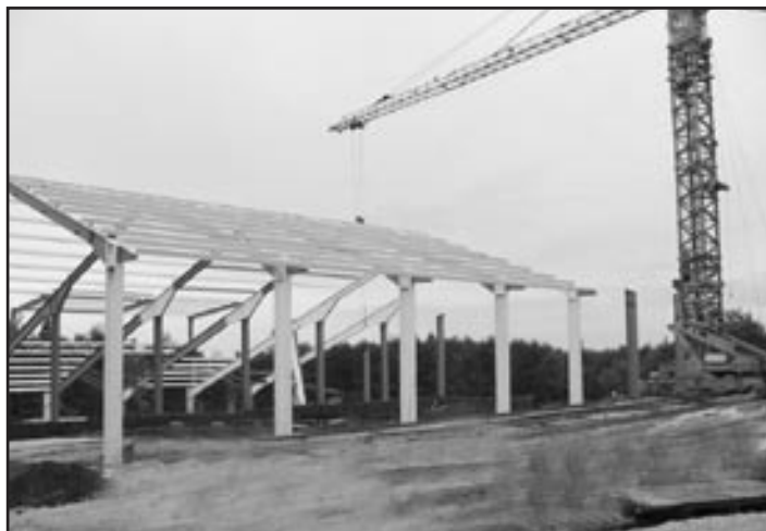
Kovová konštrukcia haly už stojí
