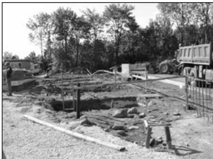
Stavebné práce na Skalke sú v plnom prúde
