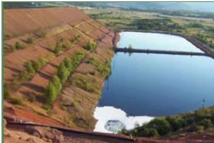
Bazény s kontaminovanou vodou.
