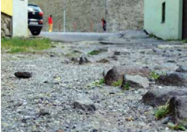
Lučanský priechod pred opravou a po oprave cesty.
